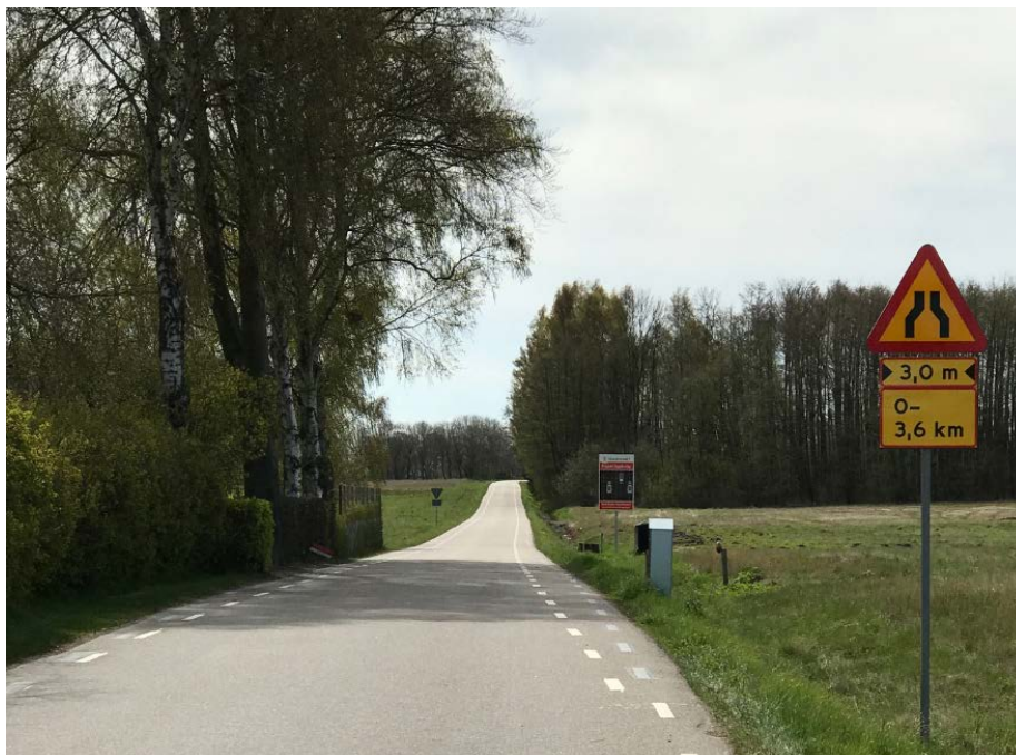
Figur 5. Exempel på utmärkning i början på objekt, notera informationsskylt i bakgrunden. Den gamla ursprungliga vägmarkeringen är synlig i början på objektet.
