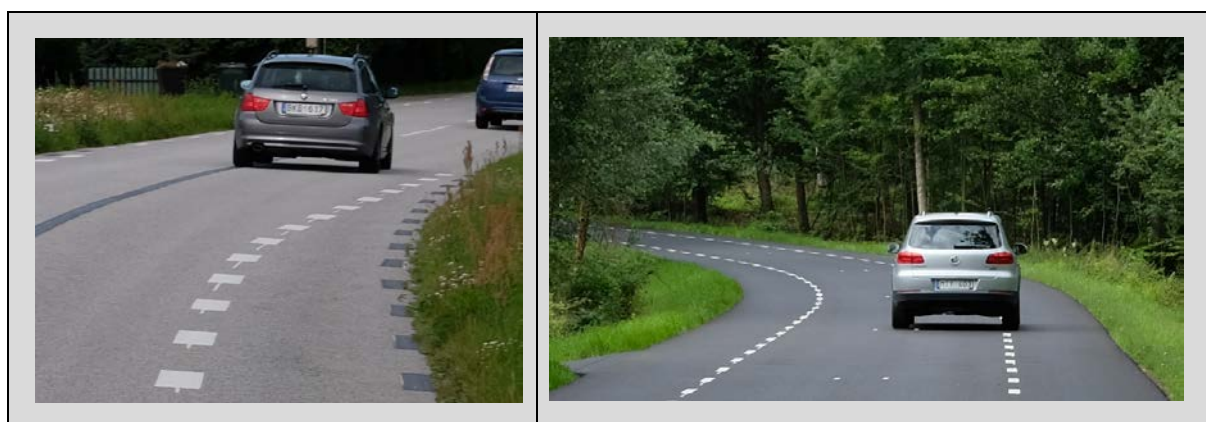
Figur 24. Exempel på utförande av vägmarkering, t.v. med "svärtning", t.h. på ny beläggning.
