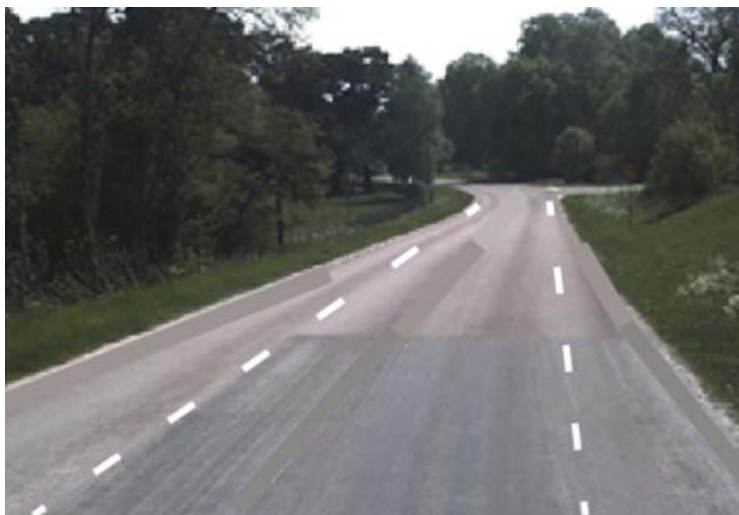
Figur 2. Exempel på utformning med kf bredd 4,5 m och vägren 1 m (källa Mats Remgård).
